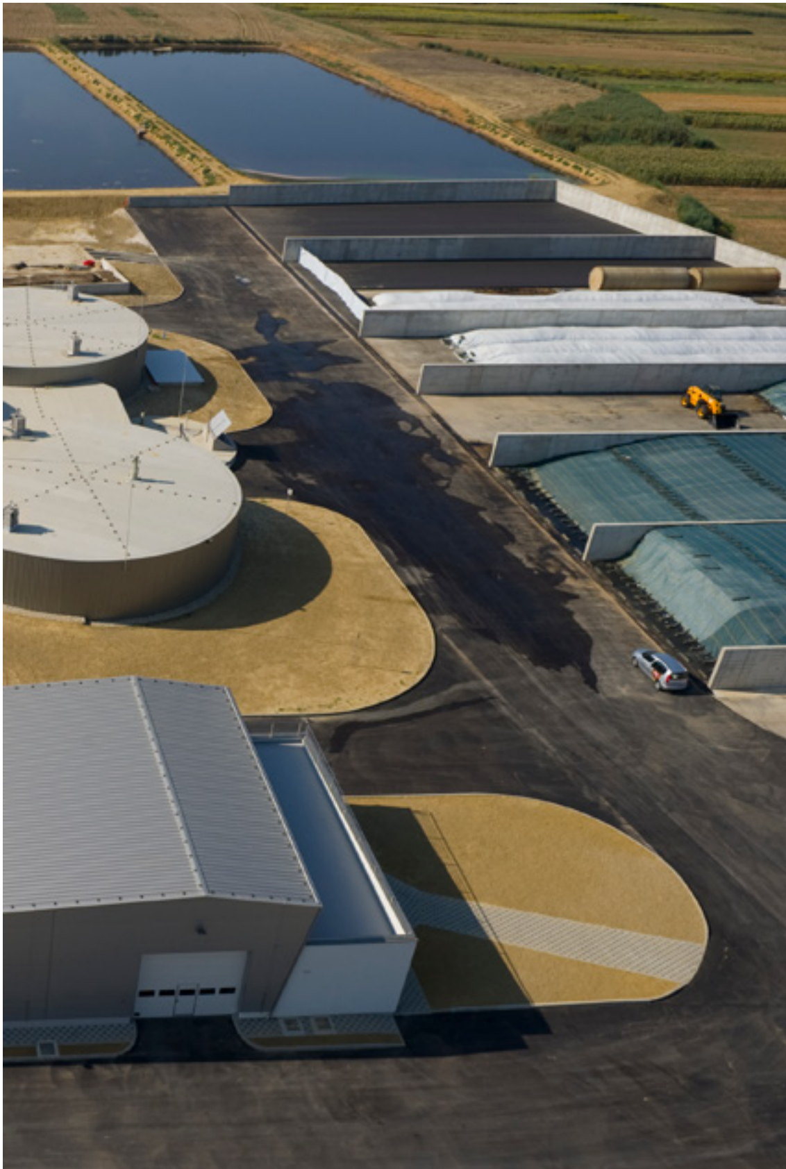
Bioplinsko postrojenje Gradec
