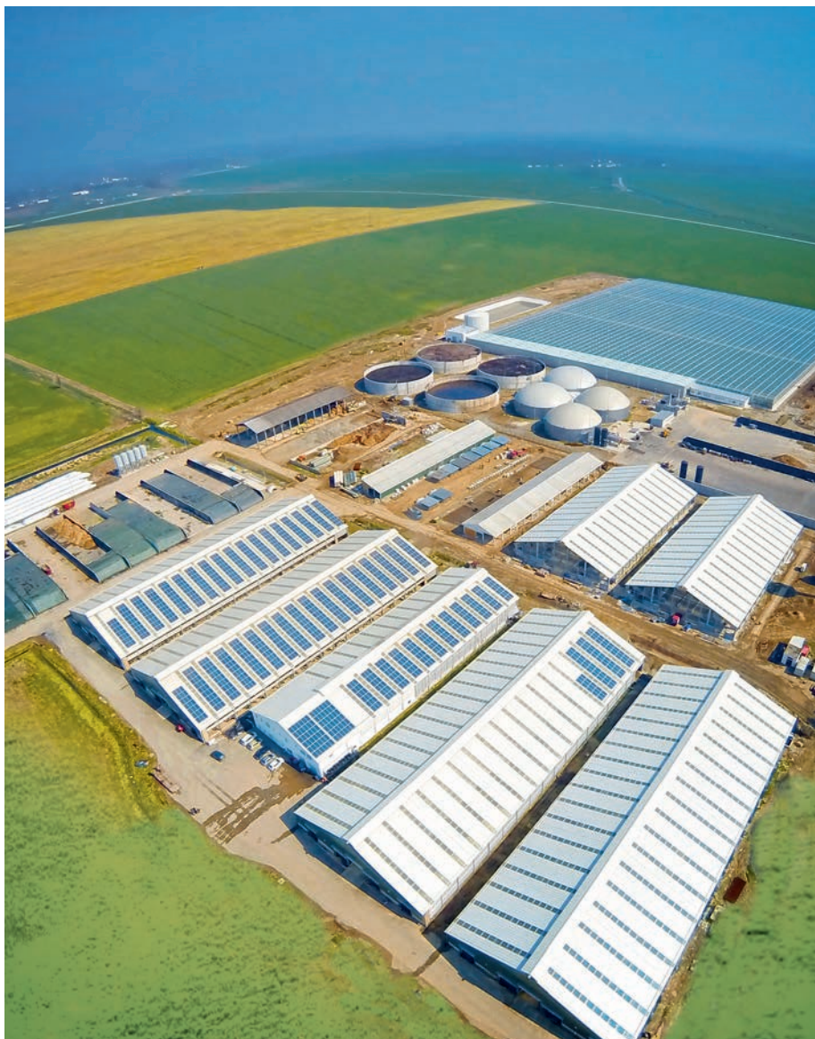
2013. godine završeni su radovi na izgradnji staklenika za hidroponsku proizvodnju grapolo rajčice na površini od 4,5 hektara. Sastoji se od farme, bioplinskog postrojenja, solarne elektrane i staklenika u kojem se iskorištava dio energije proizvedene u bioplinskom postrojenju.
